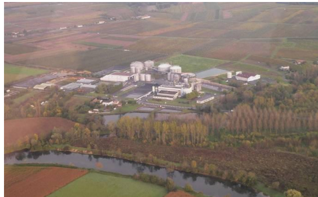
Figure 1 : Vue d'ensemble du site
