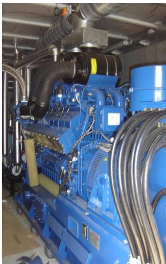
Figure 2 : équipement de cogénération – source Ferti-Nrj
