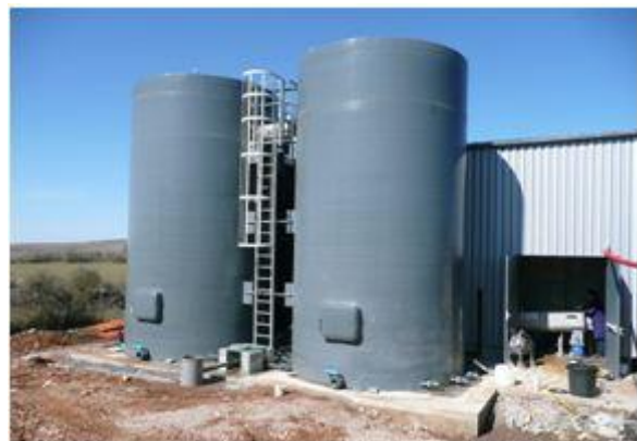
Figure 2: Vue des digesteurs - Source : ADEME
