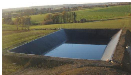
Figure 10: Lagune de stockage du digestat liquide
