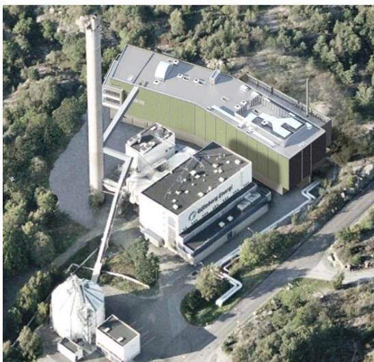
La **centrale GOBIGAS** a été inaugurée en 2014 dans la ville de Göteborg (Suède). D'une puissance de 20 MW<sub>biométhane</sub> (34 MW<sub>biomasse</sub>) elle convertit 90 000 T/an de plaquette de bois en biométhane injecté dans le réseau de transport de gaz de Swedishgas à 34 bars.
