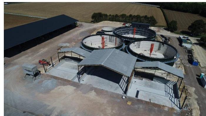
L'installations de la SAS Beaulieu MÉTHANERGIE, à Argentan en cours de construction au mois de mai/septembre dernier.
