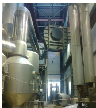
Vue du compresseur
