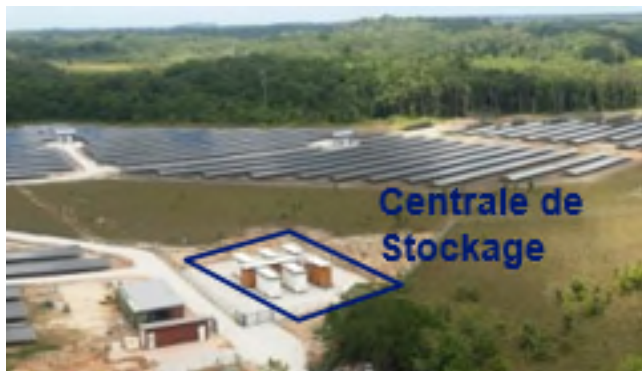
Projet TOUCAN, Guyane / Centrale hybride pour les réseaux insulaires (1,5MW - 4,5MWh)
