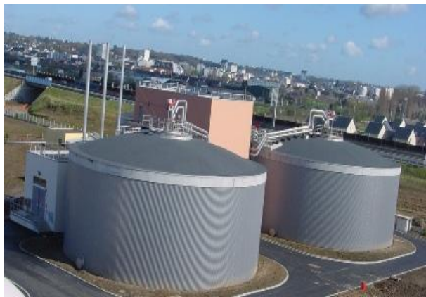
Figure 12: Digesteurs Source: Communauté d'agglomération
