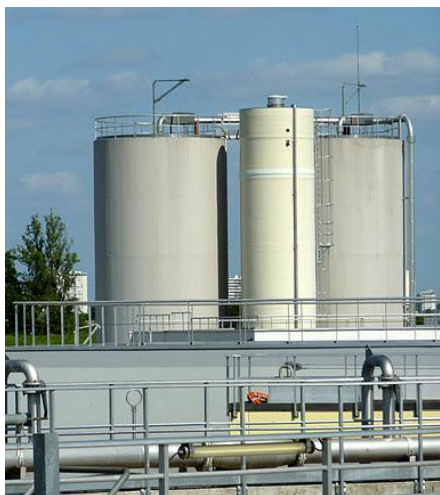
Figure 13: Silos à boues Source: Communauté d'agglomération
