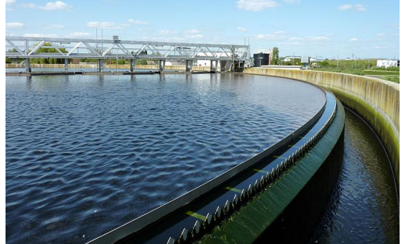
Figure 9: Clarificateur et surverse Source: Communauté d'agglomération
